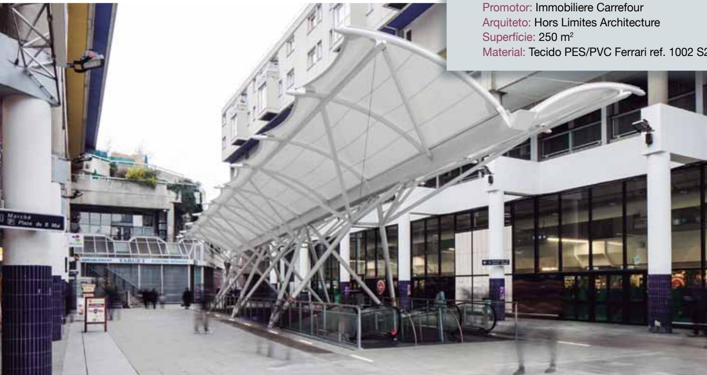
Esta nova cobertura foi projetada para a saída pedonal do estacionamento subterrâneo do centro comercial. A estrutura apoia-se sobre as duas linhas laterais da abertura no pavimento e permite a integração dos tapetes mecânicos. A membrana têxtil, formada por duas peças, segue a forma de asa presente nos elementos metálicos.
