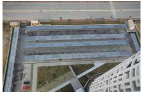
Neste edifício tão emblemático foi construído um parque de estacionamento exterior com uma estrutura metálica e uma cobertura têxtil em rede para sombra. Os pórticos, com uma distância de 5 m entre eles, têm inclinações distintas que originam uma cobertura em forma de onda.
