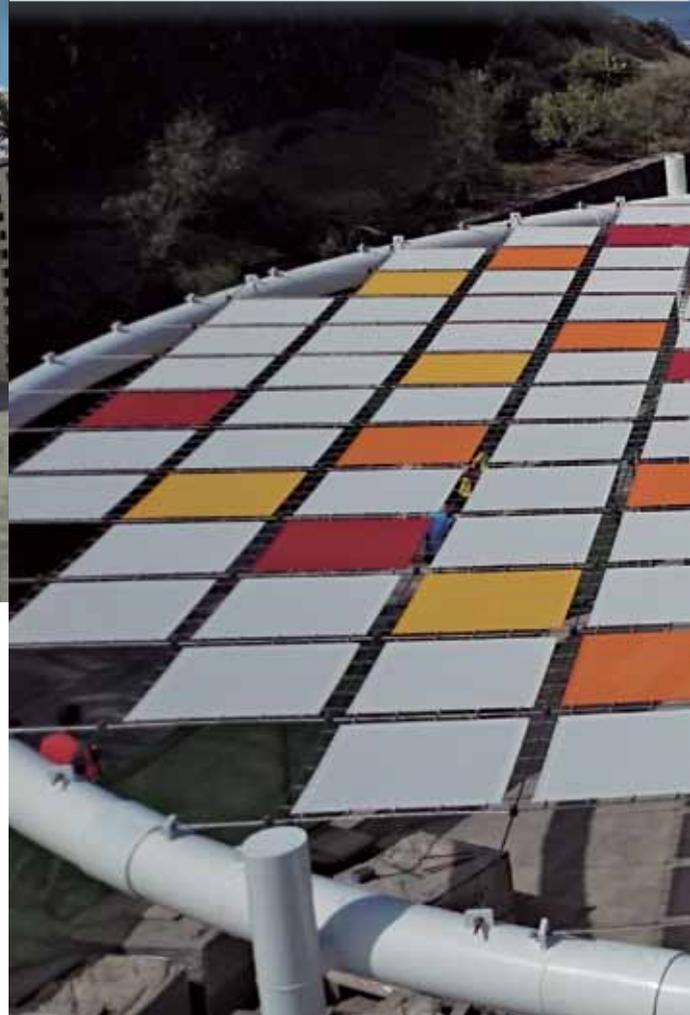
A melhoria da Rua Unterhacing no município de Adeje, província de Tenerife, compreende a cobertura de três zonas. Um total de três estruturas circulares apoiadas em três pilares com rede que proporcionam sombra nesta rua pedonal. A cobertura de cada estrutura foi realizada com uma rede de cabos de aço inoxidável e telas fixas com molas.
