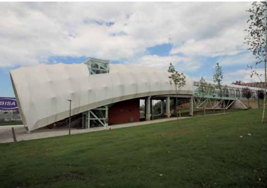
Um novo acesso para a estação de metro de Astrabudua, instalado com uma solução de estrutura metálica de nós e barras e uma cobertura têxtil. Seguindo a geometria dos nós, a tela está apoiada sobre pequenos pontos que produzem pequenos conoides na membrana, visíveis do exterior, proporcionando singularidade à envolvente.
