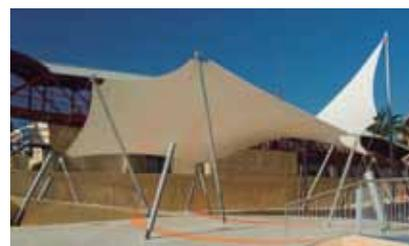
As estruturas tensionadas possuem uma tecnologia própria, baseada principalmente no comportamento do material. O requisito de uma curvatura dupla em toda a superfície da membrana têxtil condiciona a sua forma e portanto, o aspeto final. A capacidade criadora e os conhecimentos do projetista, com a utilização sistemática de programas informáticos, determinam o resultado arquitetónico definitivo.
