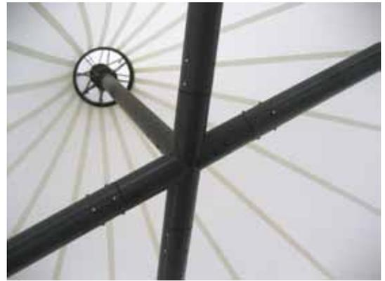
A nova estrutura tensionada para a zona de entrada e saída do porto de Valência. Duas estruturas de geometria igual cobre cada uma das zonas com 100 m<sup>2</sup> de planta. A estrutura metálica está apoiada sobre dois pilares frontais e dois arcos cruzados, emergindo estes do pavimento e superando os pilares, ficando as extremidades em projeção. A cobertura de tela maciça contém três conoides, dois deles apoiados nos dois pilares frontais e o terceiro no cruzamento dos dois arcos.
