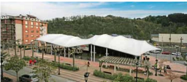
A nova cobertura do município de Beasain proporciona a proteção da chuva e do sol a uma área de jogos e um frontão. A membrana está apoiada sobre arcos metálicos dispostos obliquamente e com alturas de pilares distintas.
