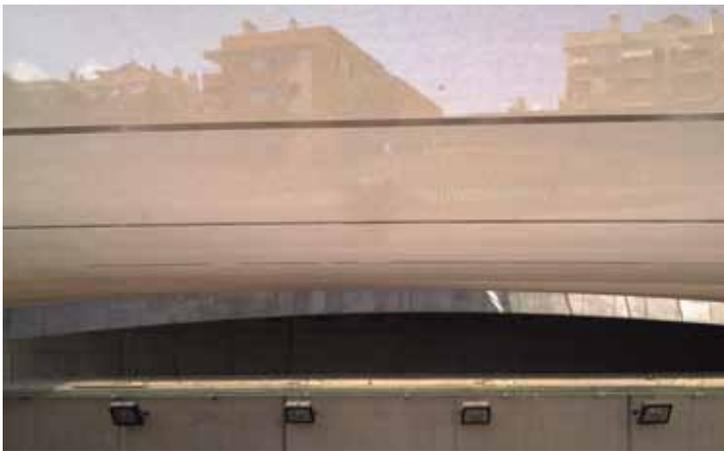
Num dos túneis da nova circunvalação do município foi instalada uma cobertura têxtil que permite ventilar a instalação. Este tecido com revestimento em teflon apresenta um comportamento muito bom perante a sujidade, e excelente durabilidade.
